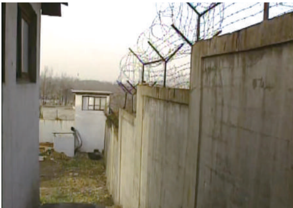
철책이 설치된 시립여자기술원(옛 서울동부여자기술원) 모습. 여성수용시설들은 원생들의 탈출을 막기 위해 높은 담과 가시철조망을 달고, 초소까지 설치해 외부와의 소통을 차단했다. @SBS 방송 캡처
